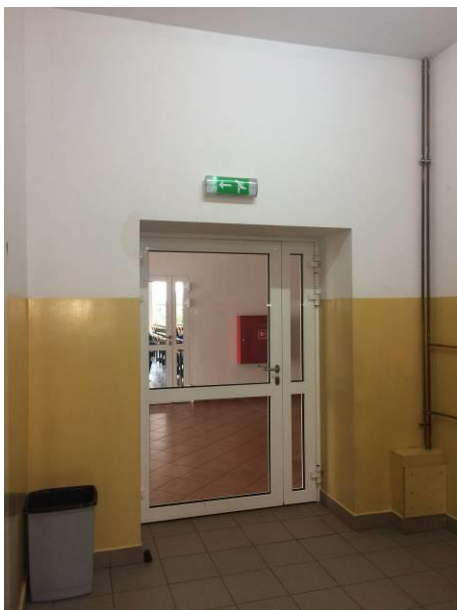
FOT. WITRYNA - WYJŚCIE OD STRONY CZĘŚCI DYDAKTYCZNEJ I WIDOWISKOWEJ
